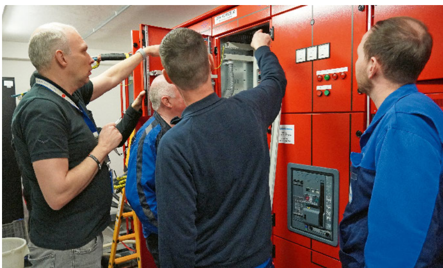
Heiko Stenzel (li.) vom technischen Gebäudemanagement beim Aufbau der neuen Schaltanlage.
