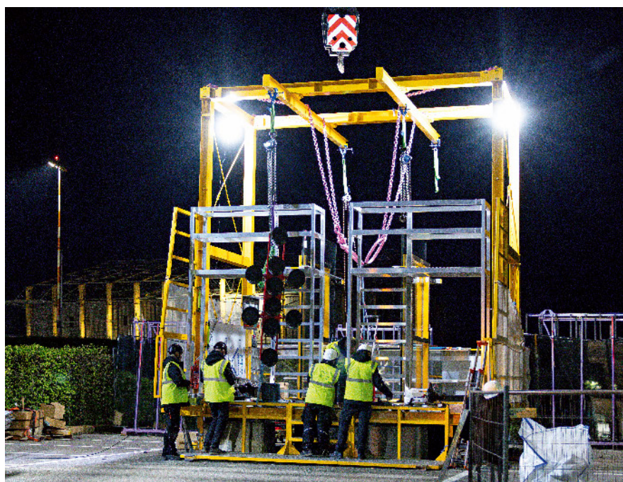
Die von der Planungsgesellschaft Langos beauftragten Experten der GF Metallbau GmbH bereiten die Montageplattform für die Fensterarbeiten vor.
