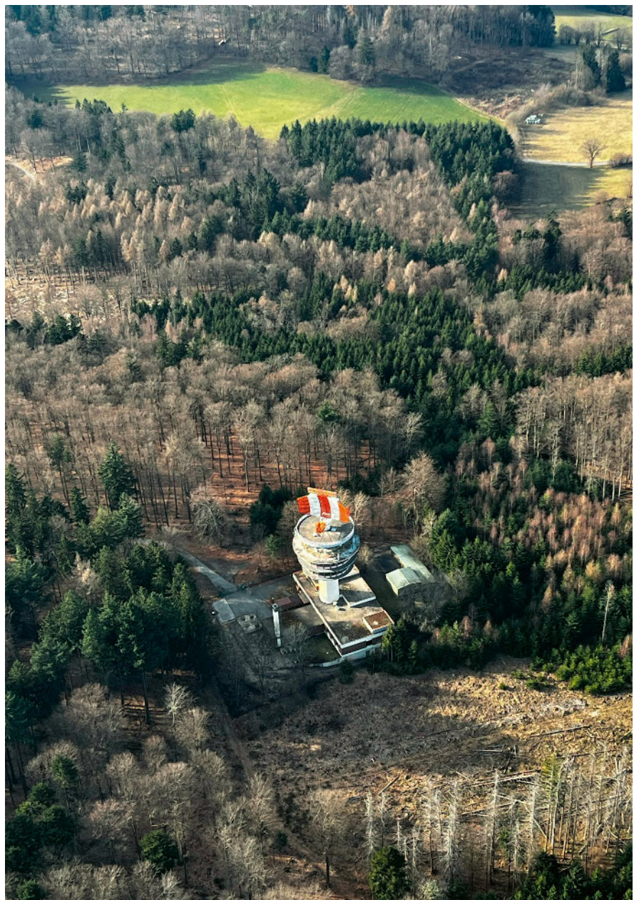
Die DFS-Radaranlage Neunkircher Höhe muss vorrangig modernisiert werden. Sie stammt noch aus den 1980er-Jahren.
