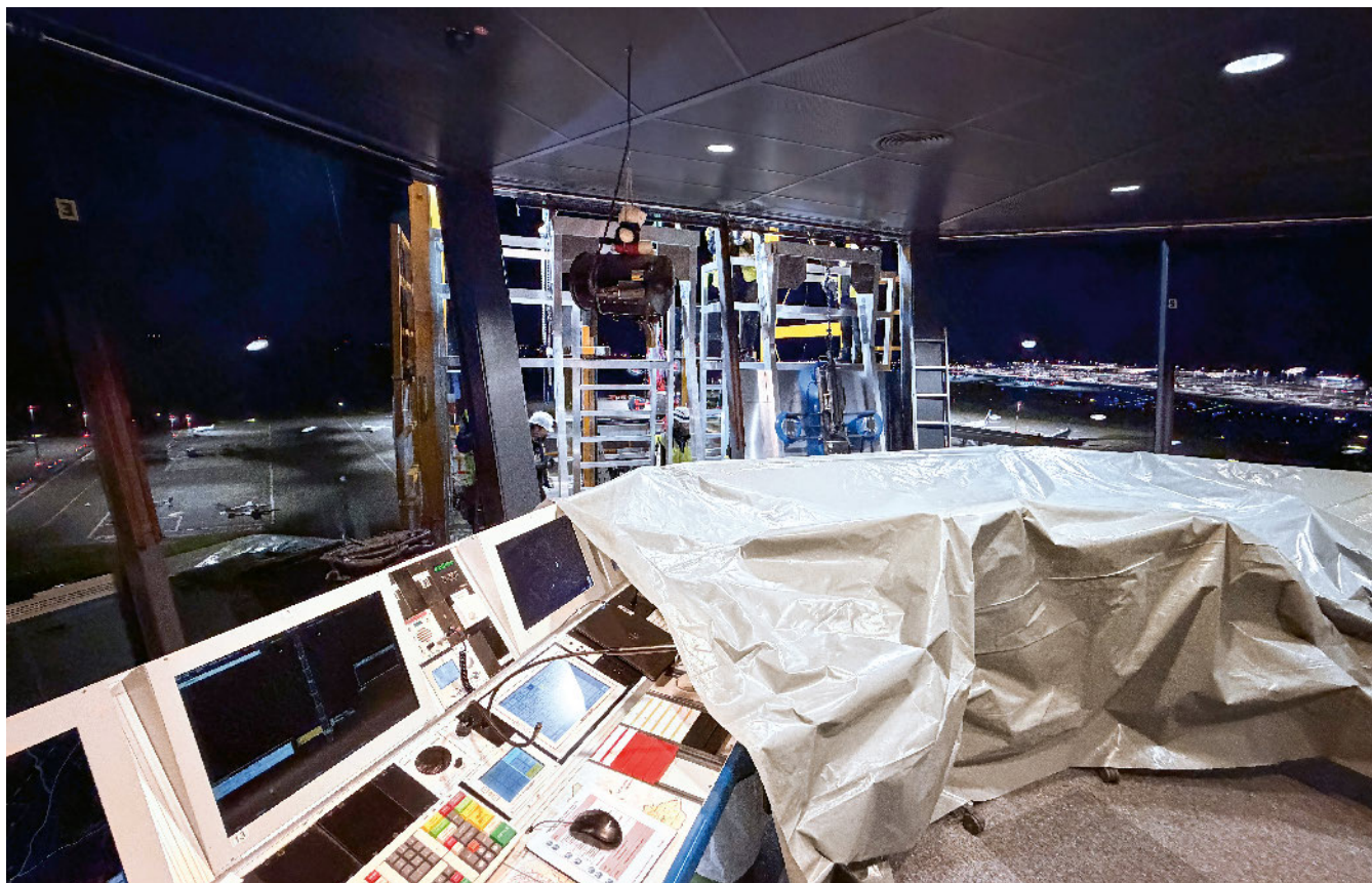
Die Arbeitsplätze wurden während der Bauarbeiten abgedeckt, damit sie keinen Schaden nehmen. Fotos: Oliver Sorg/ Hamburg Airport
