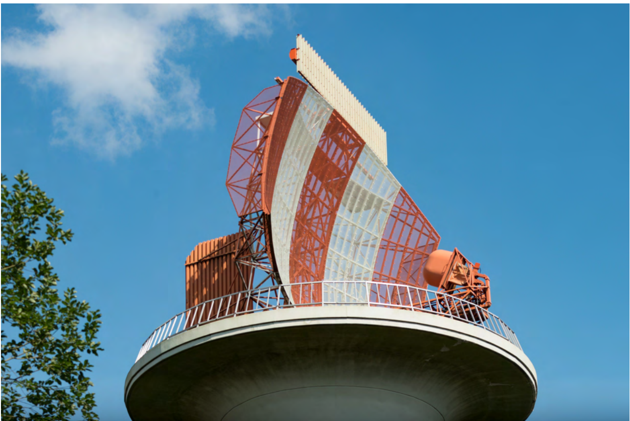
Auf dem Deister (Bremen) steht eine von etwa 40 Radaranlagen der DFS. (Foto: DFS)
