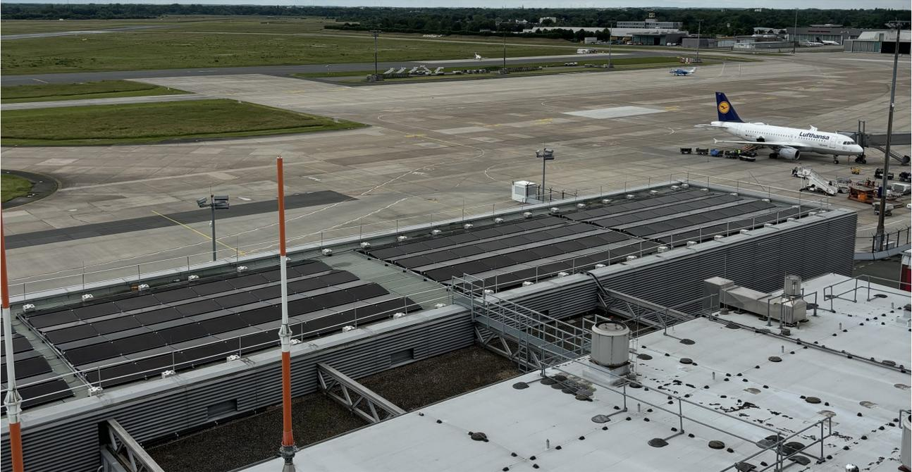
Eine Photovoltaikanlage auf dem Dach der Kontrollzentrale Bremen versorgt seit 2023 die DFS-Niederlassung mit Solarstrom. (Foto: DFS)
