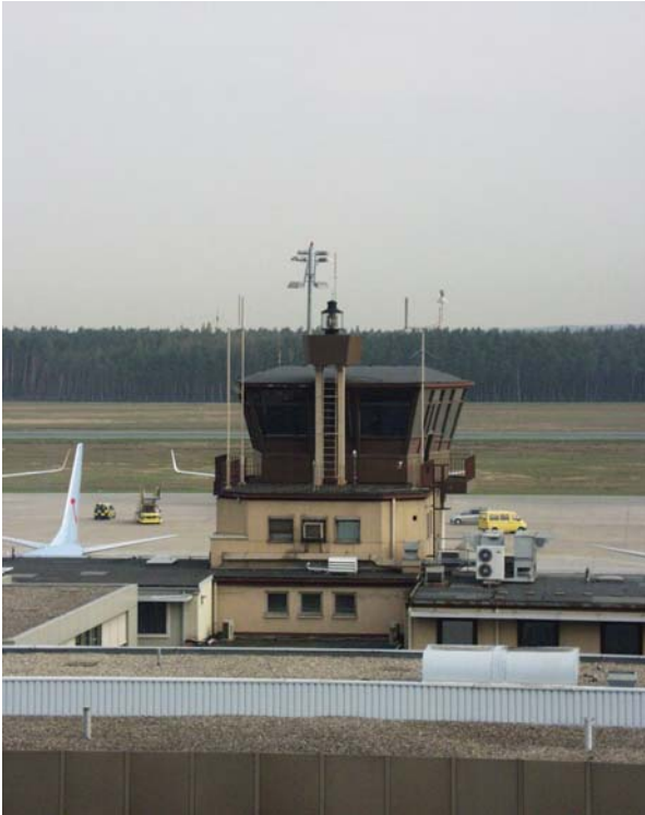
Abb. 2: „alter“ Tower in Nürnberg
